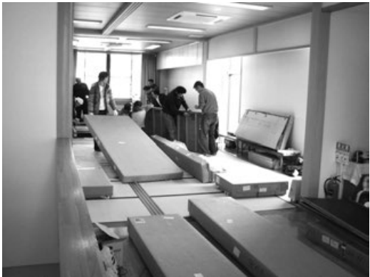
稽古場設営（春日山）部材を取り出す（平成23年3月6日9:09撮影）
