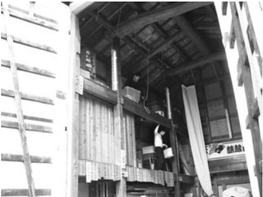
稽古場設営（諫鼓山）部材を取り出す（平成23年3月12日10:14撮影）
